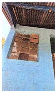
Foto 27: reparaciones de ventanas ambiente 3, sustitución de vidrios
