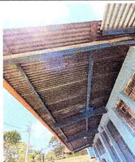
Foto 3: estructura de soporte de metal. Aula 1
