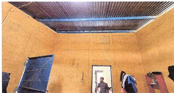
Foto 23: pintura interior, ambiente 5
