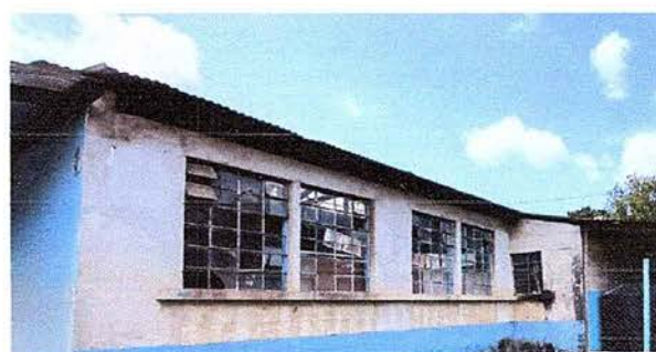
Foto 26: reparaciones de ventanas, ambiente 2. sustitución de vidrios
