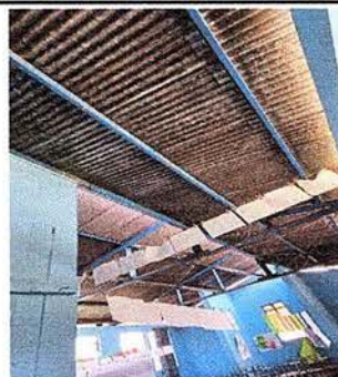
Foto 4: estructura de soporte de metal. Aula 1
