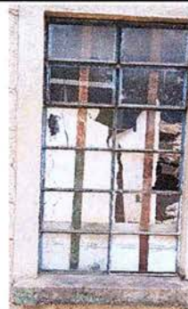
Foto 28: reparaciones de ventana ambiente 4, sustitución de vidrios
