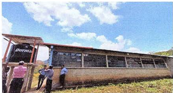
Foto 13: sustitución de canales y bajadas pluviales 2
