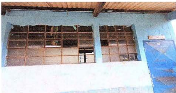
Foto 25: reparación de ventanas, ambiente 1. sustitución de vidrios
