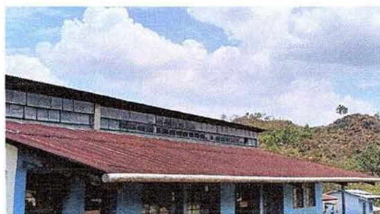
Foto 12: canales y bajadas de pluviales, necesita sustitución.
