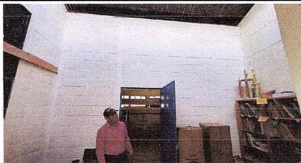
Foto 24: pintura interior, ambiente 6
